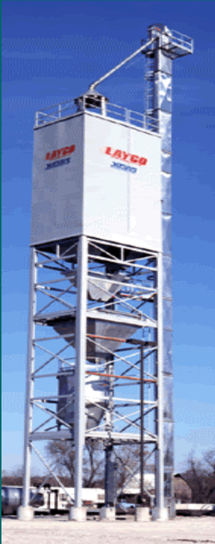
Mezclador vertical en Torre
